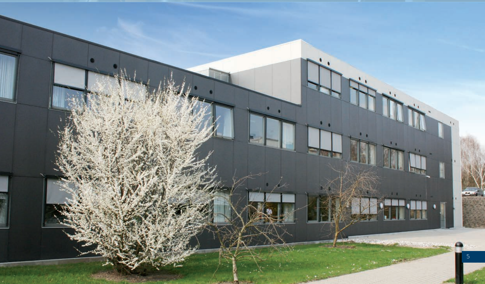
Kontorbygningen, set udefra. Indtag og afkast er ført ud igennem facaden og afsluttet med facaderiste.
